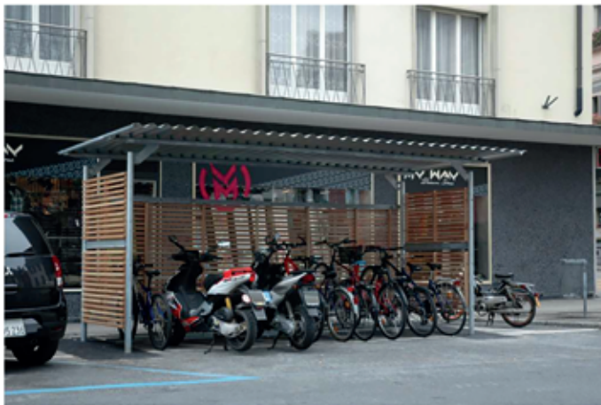
Abri deux roues à toit plat, à un seul côté, paroi en lamelles de bois
