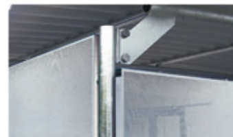
Parois en tôle percée, trous de Ø 3mm. Transparentes ou opaques en fonction de l'angle de vision.
