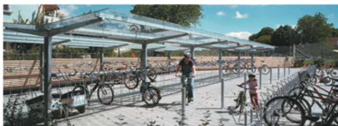
Installation de parking largement dimensionnée avec abris unilatéraux et bilatéraux. Toits en verre mastiqué en silicone discret.
