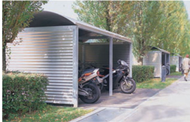
Abris avec toit décent en berceau.
