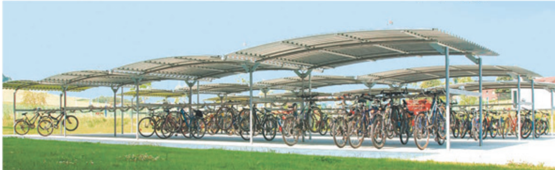
Installation d'abris bilatéraux dans un centre pédagogique. Toiture en profilés de tôles d'acier.
